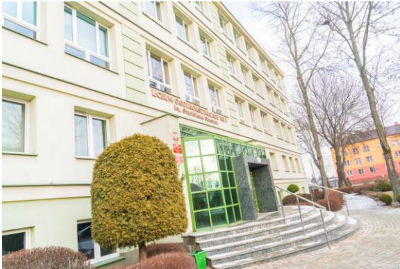
Zdjęcie budynku szkoły
